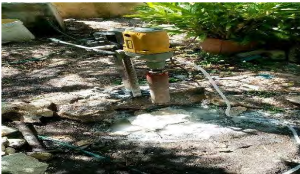
Figura 3. Equipo de extracción de núcleo de roca.
