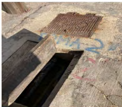
Figura 2.1 Cisterna de almacenamiento de agua potable
